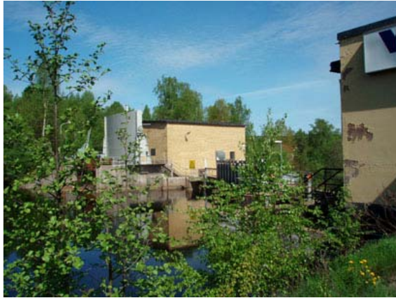
Nedre kraftstationen i Kroppstadälven
