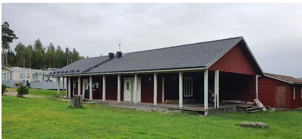
Servicebyggnad strax öster om huvudbyggnaden.
